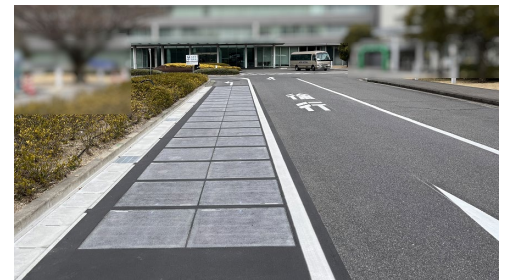
写真-2 トヨタ本社技術本館前道路（車道）
