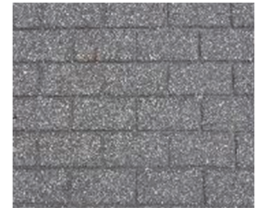
写真-5 路肩部目地
