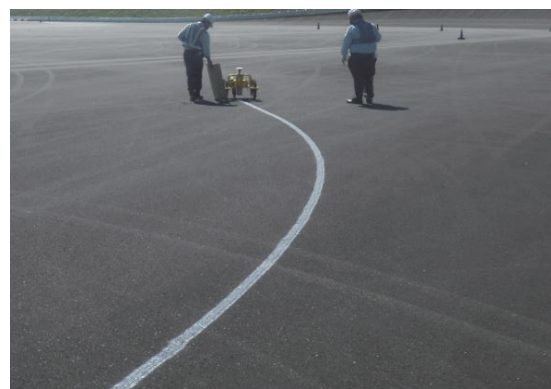
写真-2 路面転写作業状況
