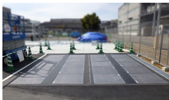
写真-1 設置した太陽光発電舗装
