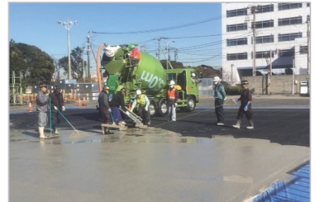
写真－４ 施工状況
