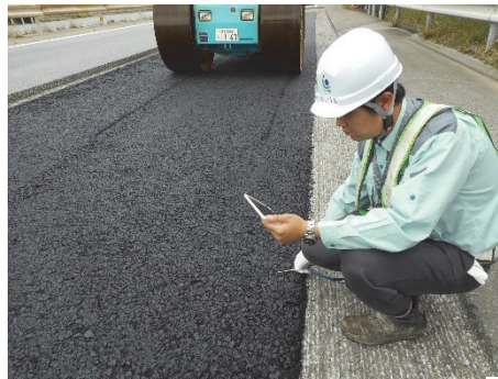
写真－3 転圧温度測定状況
