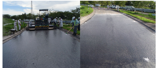
写真-2 施工状況および仕上がり面
