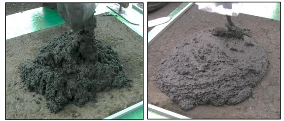
写真-3 施工状況(左:改良前、右:改良後)
