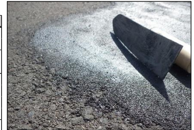
写真-4 ゼロ擦り付け状況
