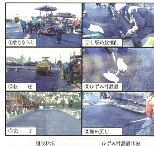
写真-3 施工状況
