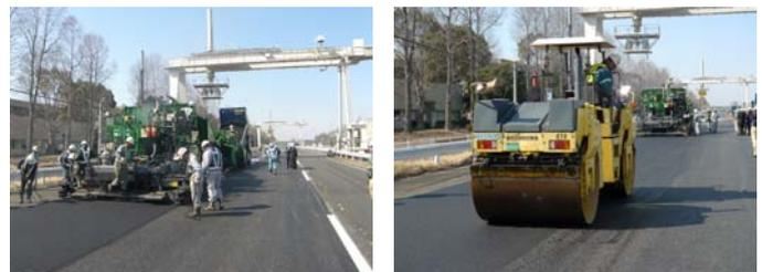
写真-1 低燃費型アスファルト混合物の試験施工状況
