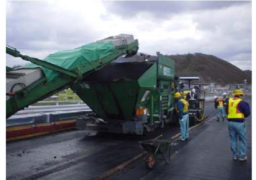
写真-1 2層同時舗設工法の施工状況
