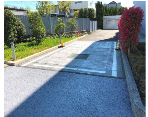
写真-1 建物北側に設置した試験施工箇所 (2箇所の黄色カラーコーンに日射計を設置)
