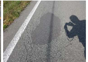
写真-8 供用7ヶ月後
