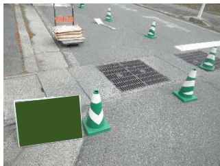
写真-4 施工箇所
