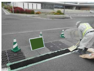
写真-5 施工状況
