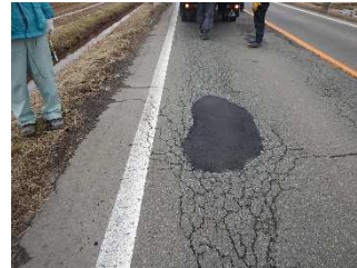
写真-7 補修直後
