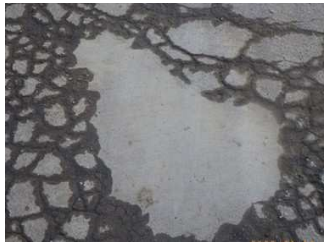
写真-2 補修3ヶ月後
