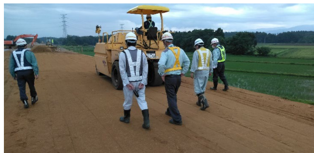
写真-1 プルーフローリング試験状況
