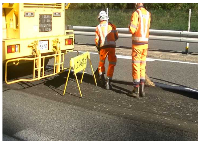
写真-1 路面清掃状況
