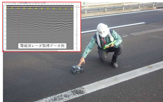
写真-5 電磁波レーダ計測状況
