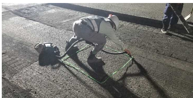
写真-4 残廃材回収状況
