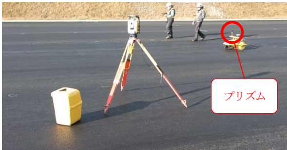
写真-8 自動走行ロボットでの検測状況
