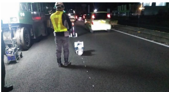
写真-7 現場供用試験状況
