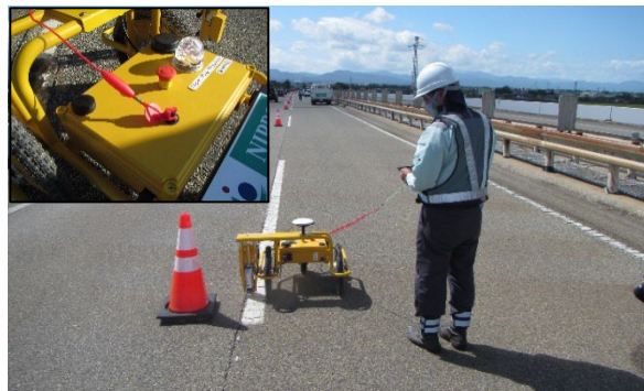
写真-4 規制際での自動走行ロボット作業と非常停止スイッチ (左上)
