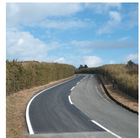
写真-3 試験舗装完成状況
