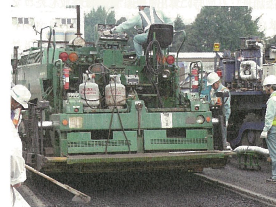
写真-5 再生基層敷きならし状況
