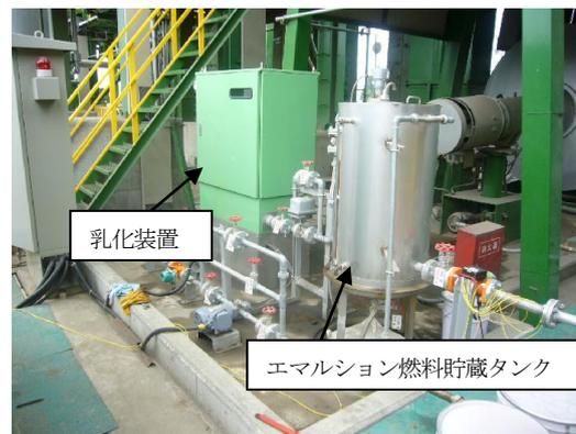
写真-4 機械式剪断型乳化装置設置状況
