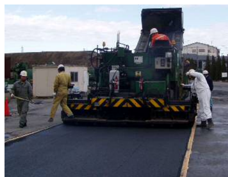
写真-3 試験施工状況
