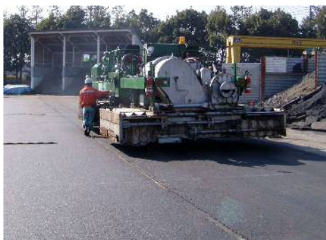
写真-4 路面加熱状況
