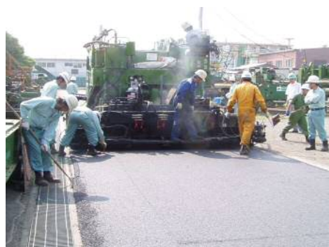
写真-5 施工状況
