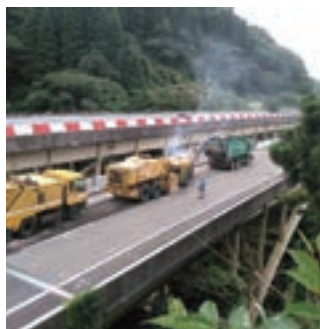
北陸自動車道 加賀IC～小矢部IC間 舗装補修工事 (2019年度)
