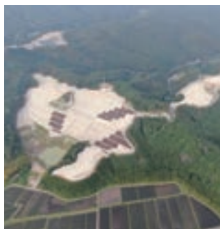
株式会社神戸物産西白河郡 太陽光発電所土木工事
