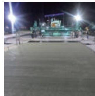
那覇空港滑走路改良工事
