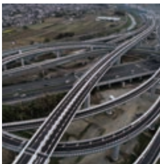
高速横浜環状北西線他舗装他工事
