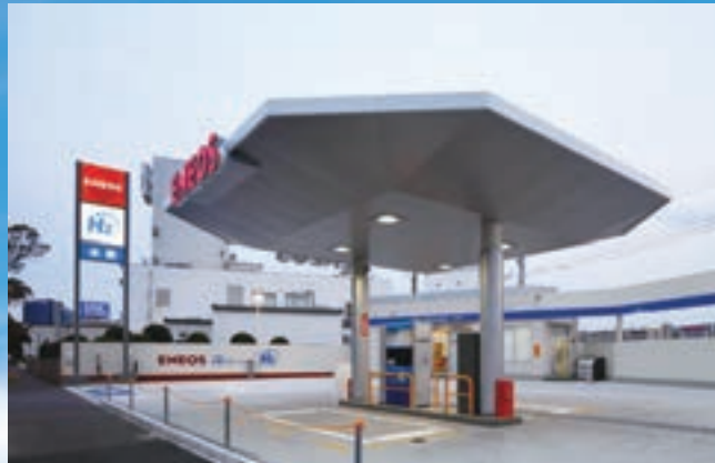
千葉幕張水素ステーション 建設工事(設計・施工)
