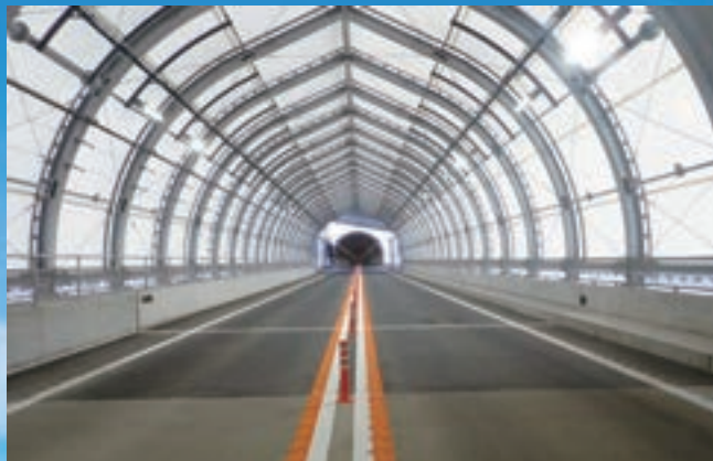
北海道横断自動車道 小樽東舗装工事
