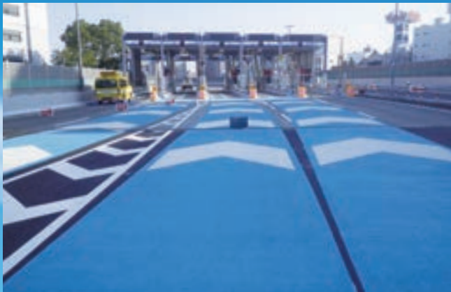
舗装補修工事（29-5-1堺）
