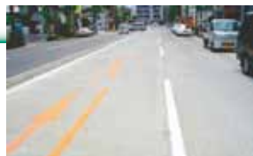
車道での保水性舗装の施工例
