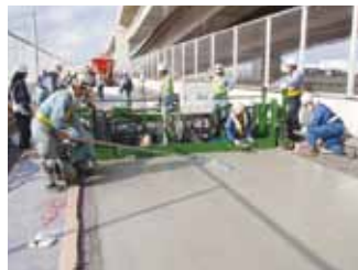
NIPPOが開発した「スマートフィニッシュ」による鋼床版補強用SFRC舗装の施工風景
