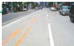
車道での保水性舗装の施工例
