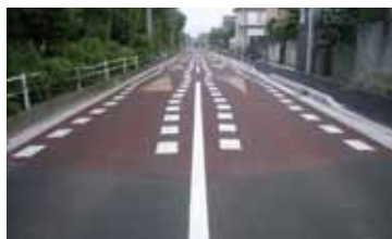
カラー舗装によるスピードセーブ工法
