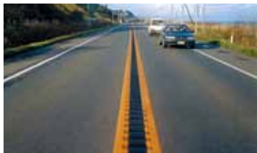
センターライン型のランブルストリップス (独)土木研究所 寒地土木研究所と共同開発
