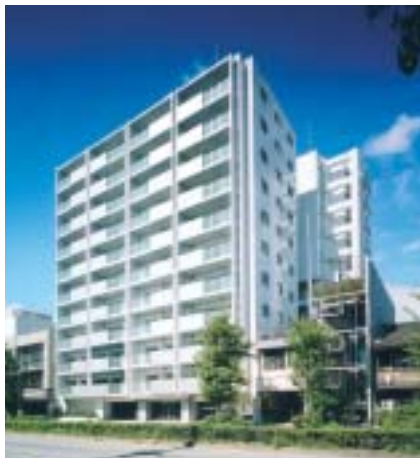
● マンション新築工事 【京都府】
