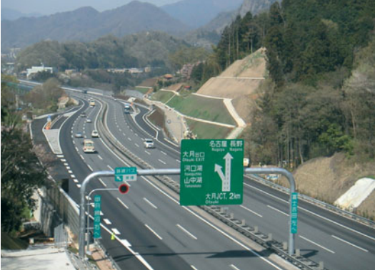
● 中央自動車道大月東舗装工事 【山梨県】
