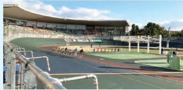
名古屋競輪場走路改修工事 名古屋競輪組合
