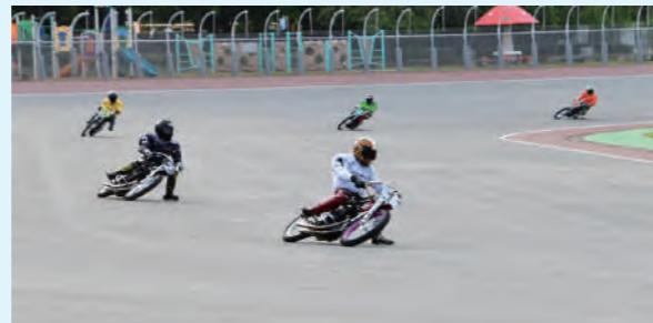
伊勢崎オートレース場競走路改修工事 東京都競馬株式会社
