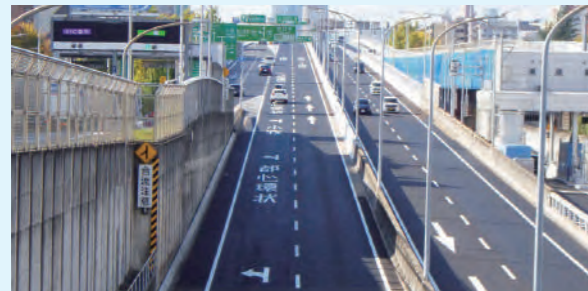
令和5年度高速2号東山線舗装修繕工事(第4工区) 名古屋高速道路公社
