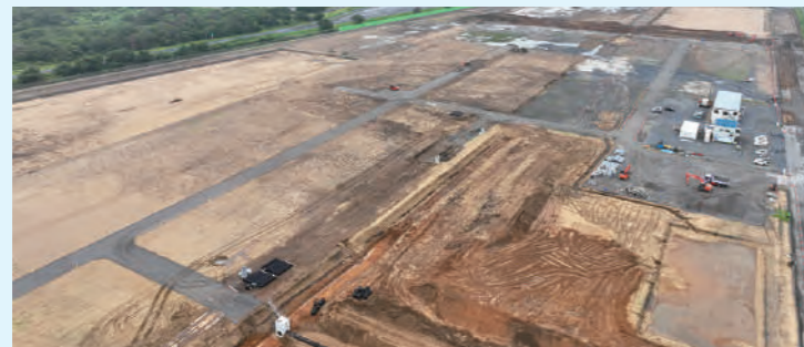
ひたちなか複合工場敷地造成工事その1 JX金属株式会社
