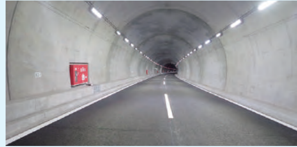
姫路高速道路事務所管内舗装補修工事(令和3年度) 西日本高速道路株式会社
