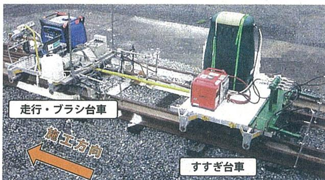
NIPPPOは、夏場の気温上昇による膨張を抑えるために遮熱塗料を塗った軌道の洗浄システムを開発した。回転ブラシやタンクを備えた専用台車がレール上を走り、洗浄とすすぎを連続的に行う仕組み。表面の汚れを効率良く取り除くことができ、塗料を塗り直さずに遮熱機能を回復させられる。軌道の熱膨張対策に遮熱塗料を採用する鉄
