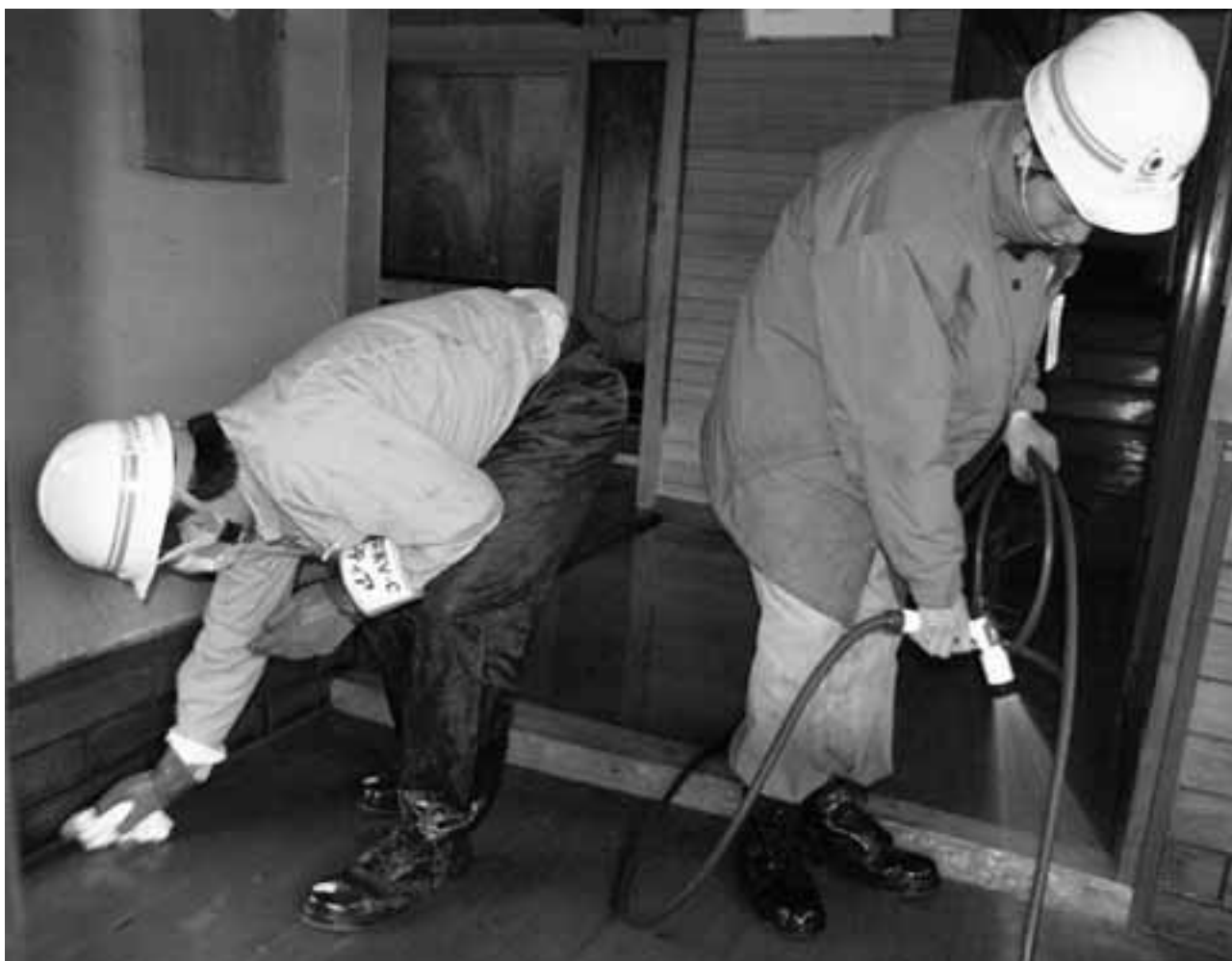
(㈱NIPPPOに今春入社した新人男性社員が多賀城市内でボランティア活動を行っている(津波で家の中にとまった泥の排出作業の様子：大代地区)
