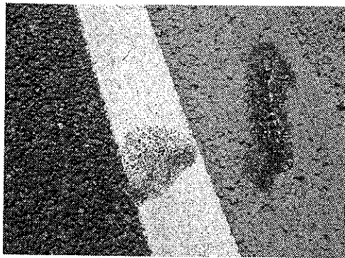
発煙筒の燃えかすで区画線やカラー舗装が損傷するケースが見受けられた
