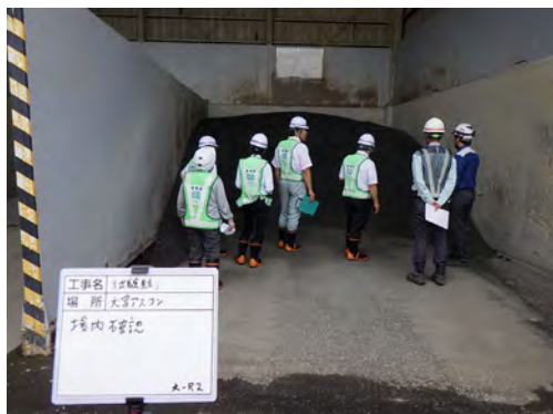
写真-5 道建協による新規骨材及び再生骨材の保管状況の確認
