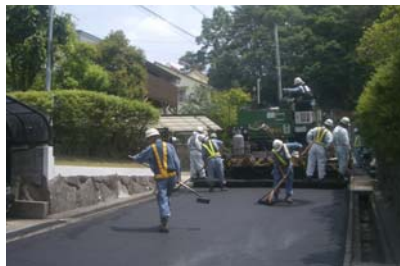
写真-3 施工状況
