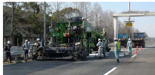
写真-3 試験施工の状況 (2層同時舗設式小粒径薄層舗装)
