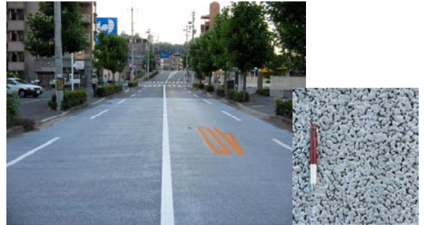
写真-2 実路試験舗装(手前が NOx 遮熱工区)
