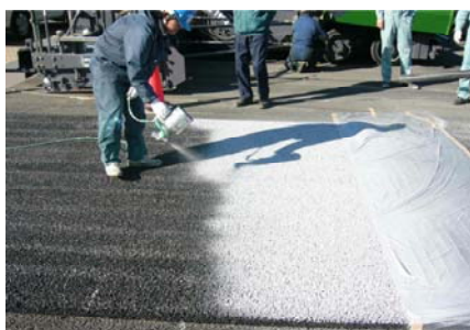
写真-1 コート材の塗布状況(構内試験施工)
