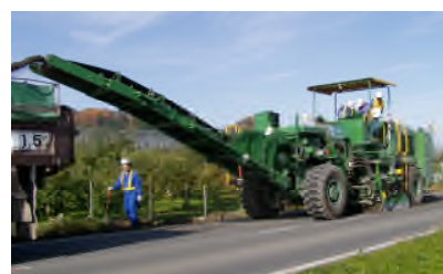
写真-3 既設アスコンの撤去状況
