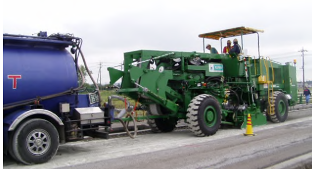
写真-6 セメント・フォームドアスファルト混合状況
