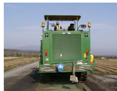
写真-4 既設路盤材のすき取り状況
