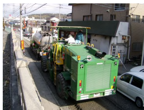
写真-1 狭隘な地方道での工事例
