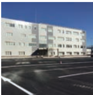
関東支社 岩槻社屋新築工事
