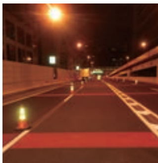
(修) 舗装改修工事1-207
