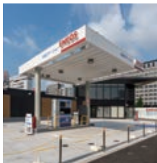
東京高輪水素ステーション 建設（設計・施工）工事
