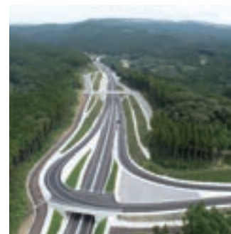
令和元年度災害復旧 熊本57号 古城地区舗装（その1）工事
