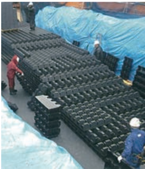
国道50号での施工風景
