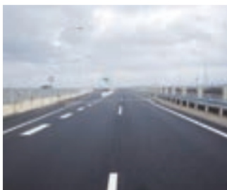
館山自動車道 アクア管内舗装補修工事
