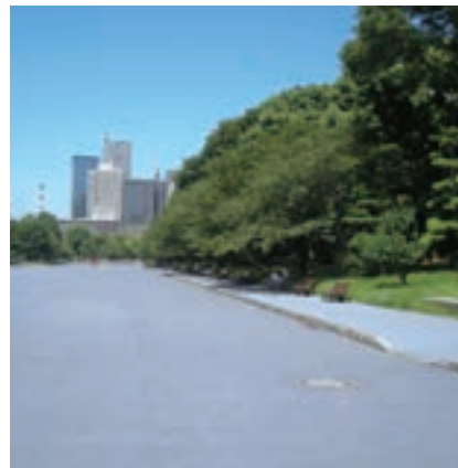
施工完了時の皇居前広場の様子
