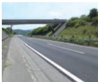
高松自動車道 引田IC～三島川之江IC間舗装補修工事
