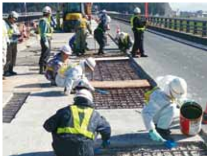
断面修復工法での使用状況
