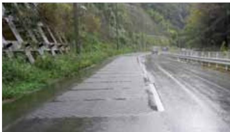
福岡県内での施工例（左側車線）
