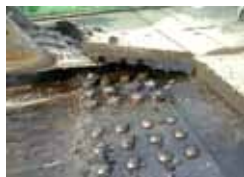
スマートリムーブ工法による剥ぎ取り (約70 ~ 80dB)
