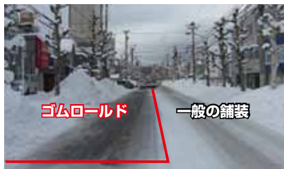
青森県青森市での施工例 一般の舗装では表面に氷盤が形成されているが、ゴムロールドは剥がれている
