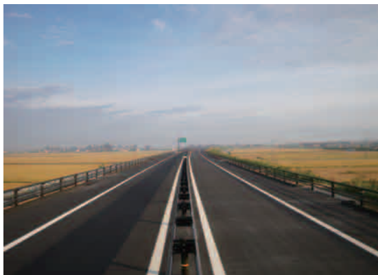
● 国土交通省 東北地方整備局 塩川地区舗装工事 【福島県】
