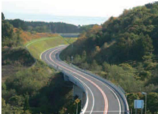
● 東日本高速道路株式会社 北海道支社 北海道縦貫自動車道 落部舗装工事 【北海道】
