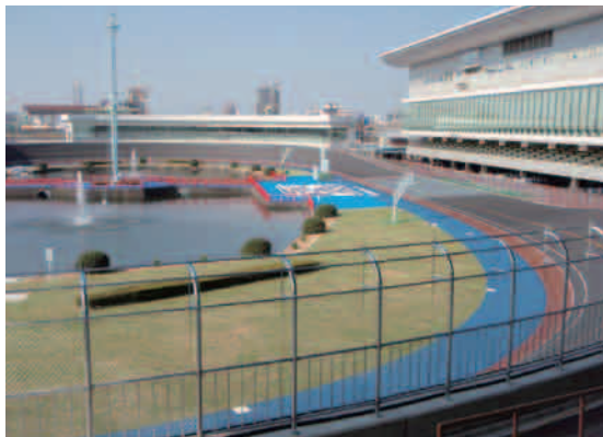
● 岐阜市 岐阜競輪場競争路改修工事 【岐阜県】
