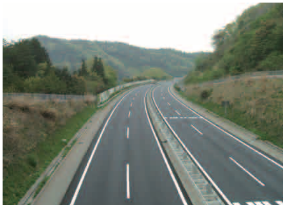
● 西日本高速道路株式会社 中国支社 山陽自動車道 福山管内舗装補修工事 【岡山県・広島県】
