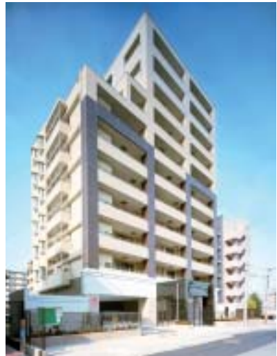
● グランスイート茨木新築工事 【大阪府】
