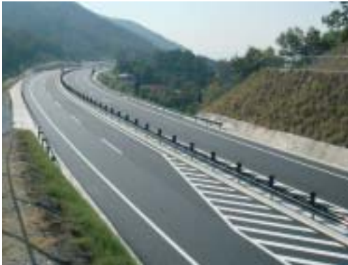
● 東広島・呉道路溝上舗装工事 【広島県】
