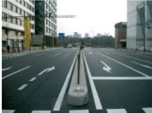
● 麹町舗装修繕工事 【東京都】
