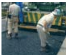
ポーラス(20)の舗設
