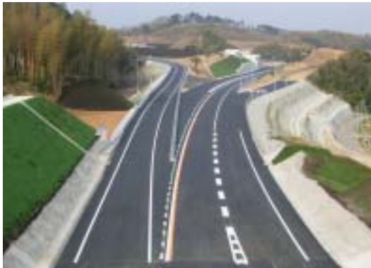
● 宮崎10号 延岡JCT舗装工事 【宮崎県】
