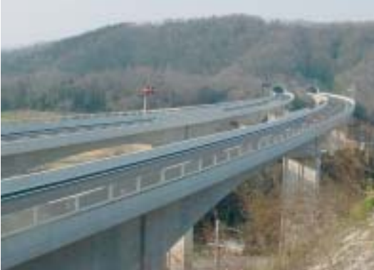
● 東海環状自動車道 豊田北舗装工事 【愛知県】
