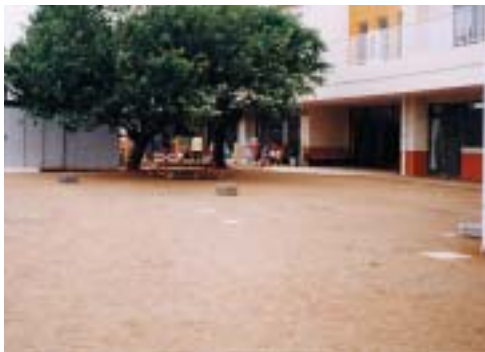
施工例：新原保育園（静岡県）
