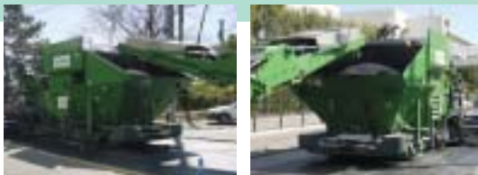
日本での施工状況
