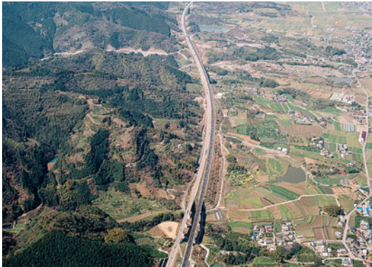
● 松山自動車道西条西 舗装工事 【愛媛県】
