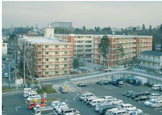
● マンション建築工事 【神奈川県】
