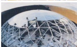
屋根パネルの組立
