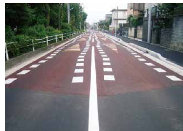
スピードセーブ工法の施工事例
